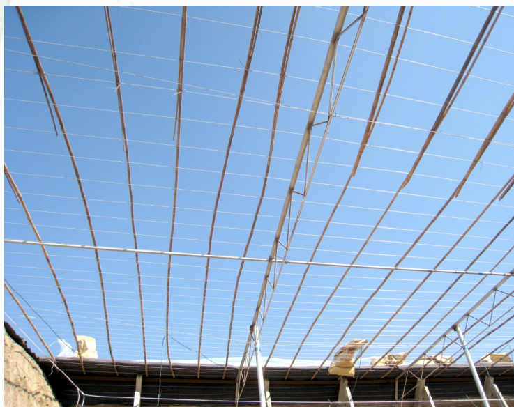
更换了镀锌钢丝的棚面
