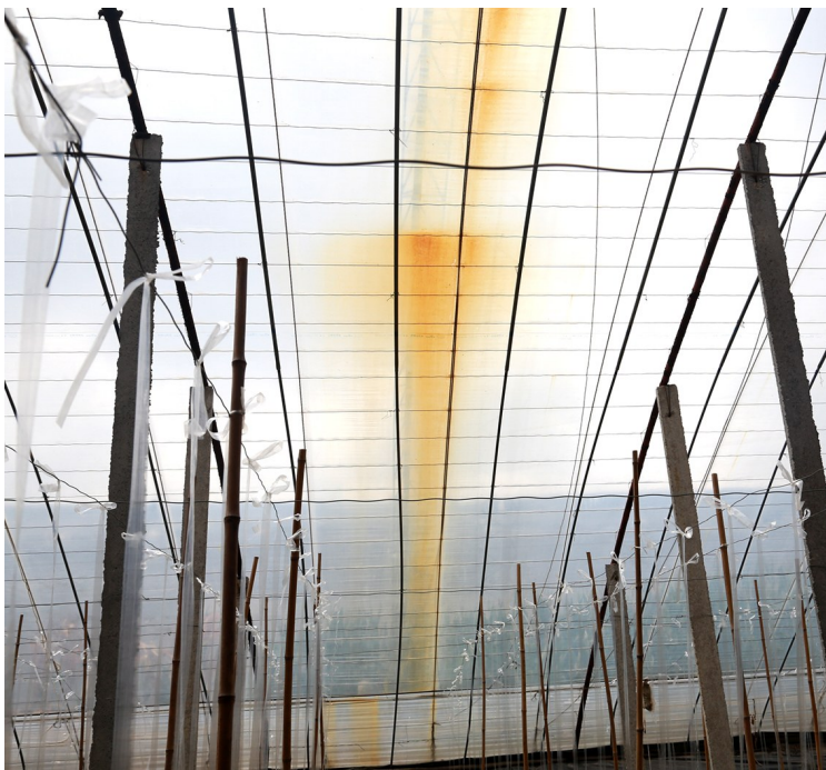
铁锈污染棚膜
