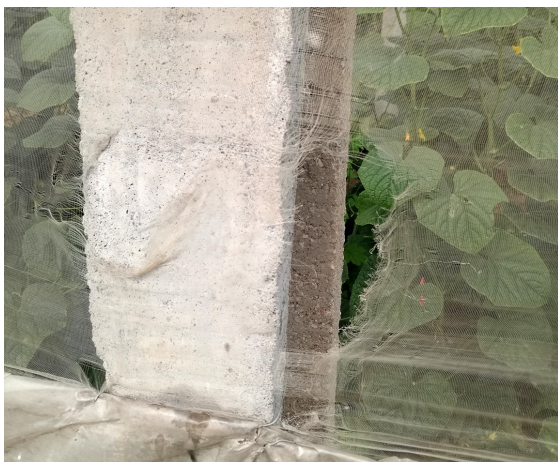
防虫网破裂
