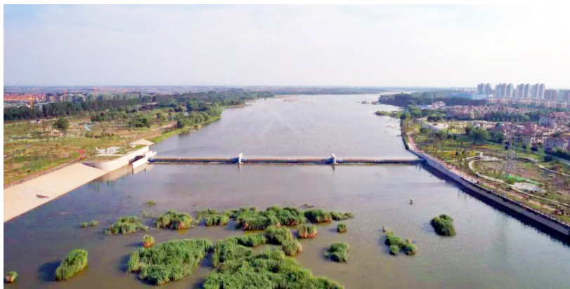
弥河王口橡胶坝拦蓄水场景。
